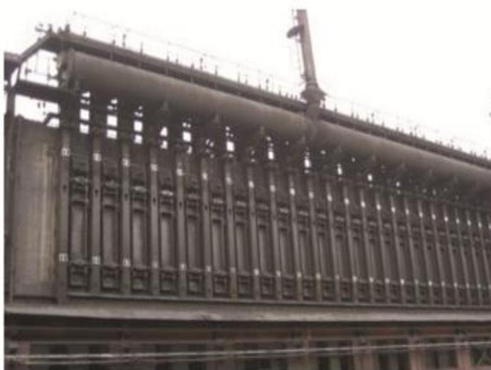
炼焦炉由炭化室、燃烧室、蓄热室、斜道区、炉顶、基础、烟道等组成。炭化室中煤料在隔绝空气条件下受热变成焦炭。烟气排放对环境的严重污染。国家2019年4月颁布超低排放标准。
